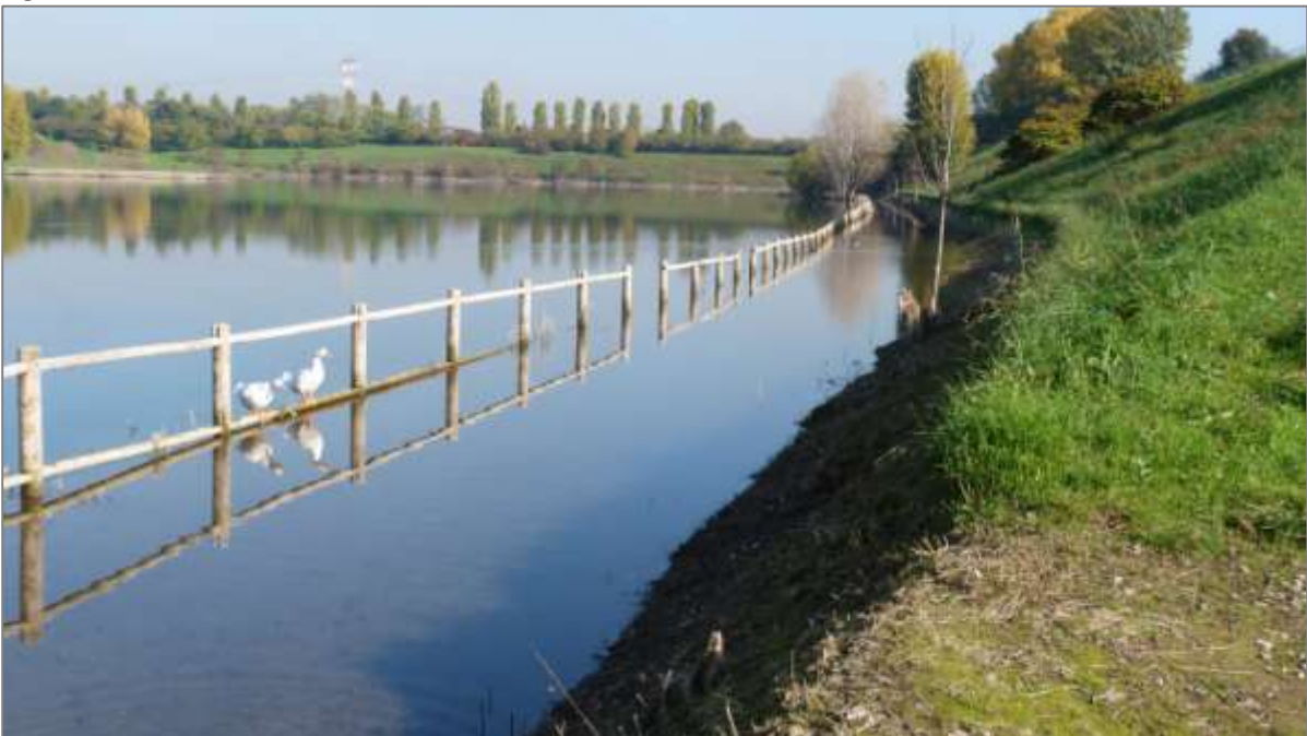
Fig. 3.30 Con falda molto alta viene sommerso il percorso perimetrale e, con le oscillazioni piezometriche, si incrementa l'erosione (foto 30/10/2015)
