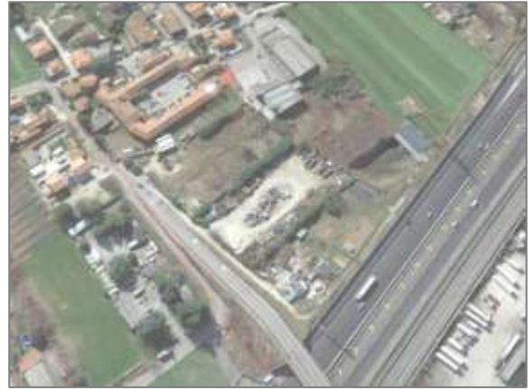
Fig. 3.19 (da nord-est) Area produttiva/deposito con scavi e cumuli persistenti in via Occhiate
